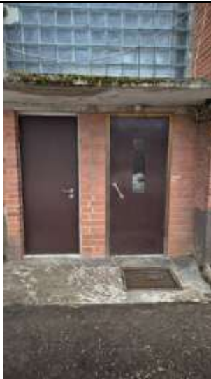
Kāpņu telpas ārdurvis
